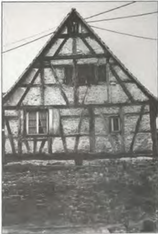
Photo ancienne de la maison
